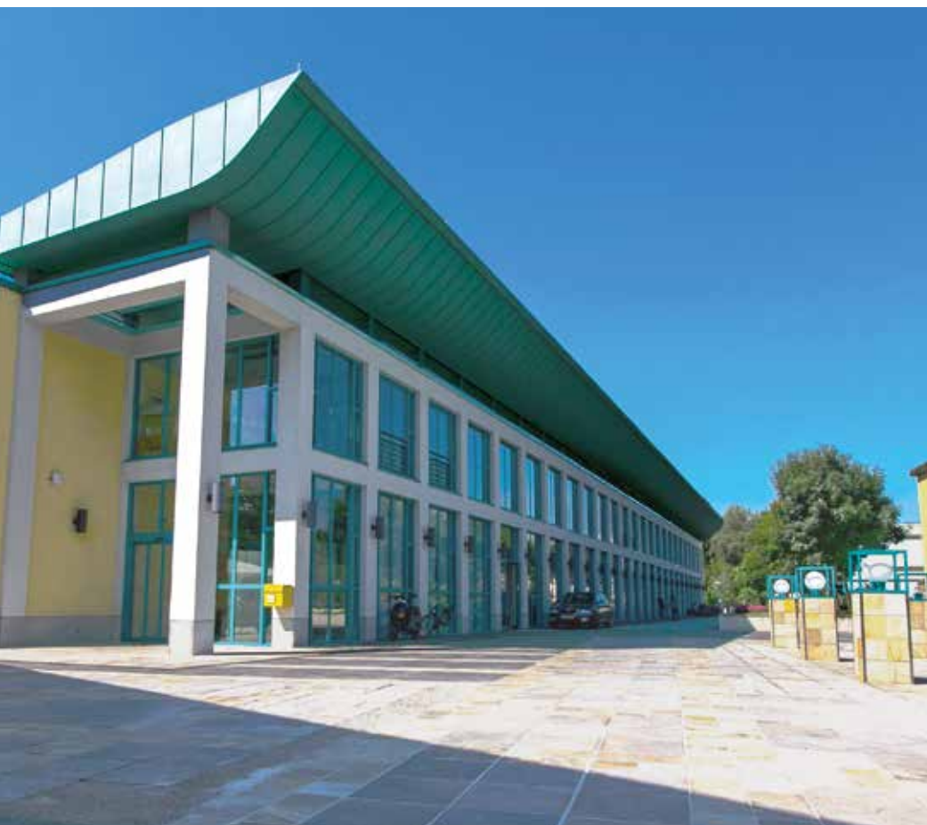
Ab September 2018 steht die Privatklinik Wehrle-Diakonissen ausschließlich in Aigen zur Verfügung.
